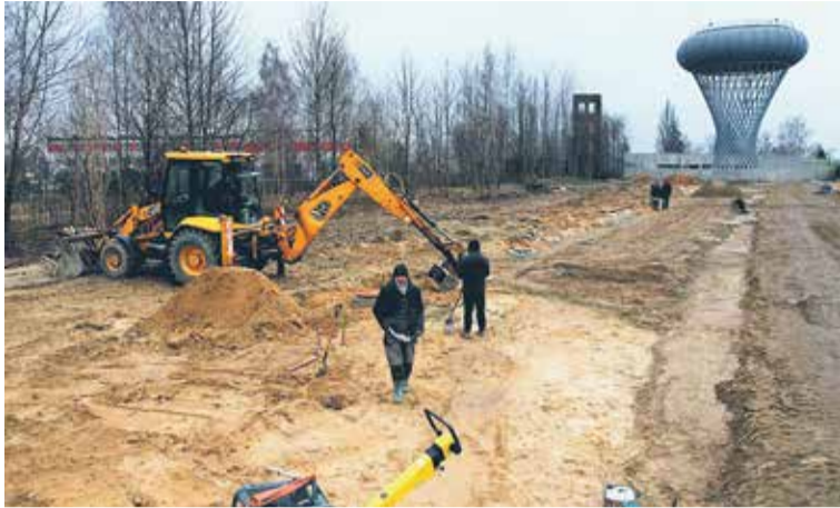
Trwa budowa nowej drogi dojazdowej do Parku Nauki Torus.
