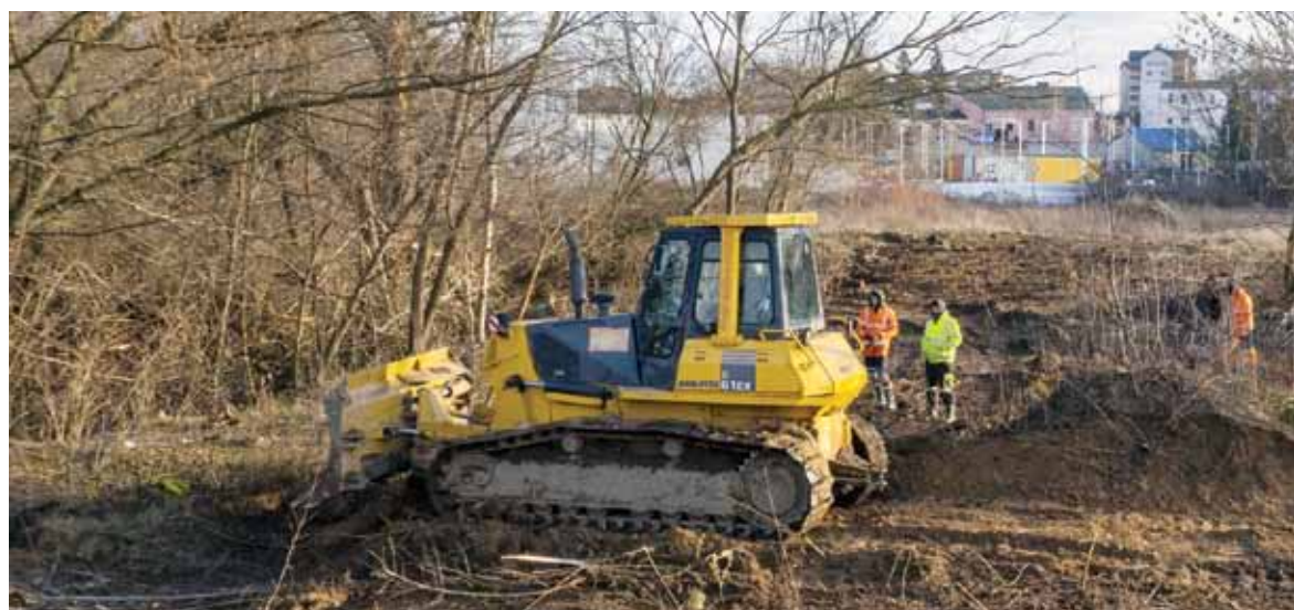
Pomiędzy ul Augustiańską i Płońską powstaje ciąg pieszo-rowerowy
