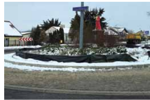
Rondo na skrzyżowaniu ulic Gruduskiej, Przasnyskiej i Wojska Polskiego w Ciechanowie zostało zmodernizowane
