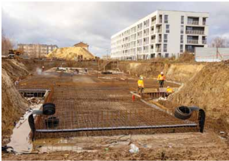
Spółeczna Inicjatywa Mieszkaniowa Północne Mazowsze buduje przy ul. Opinogórskiej dwa bliźniacze, czterokondygnacyjne budynki mieszkalne
