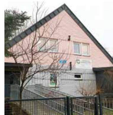
Siedziba Towarzystwa Przyjaciół Dzieci przeszła kolejny etap modernizacji.
